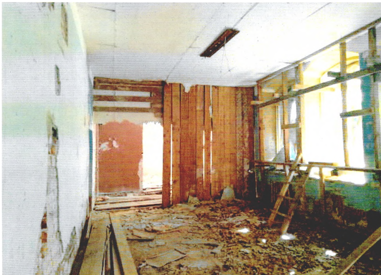
Фото 8. Фрагмент интерьер 2-го этажа.
