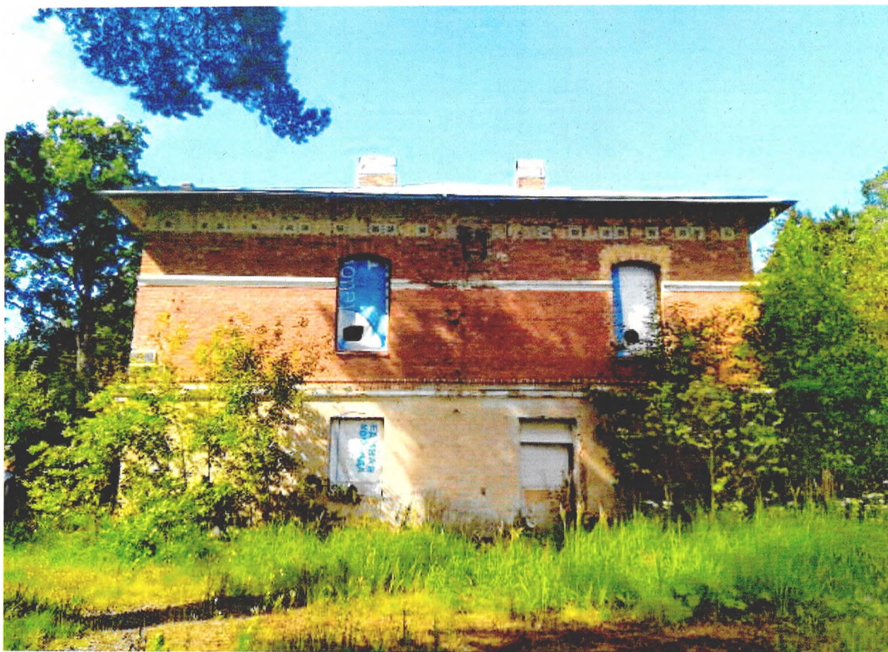
Фото 2. Восточный фасад здания
