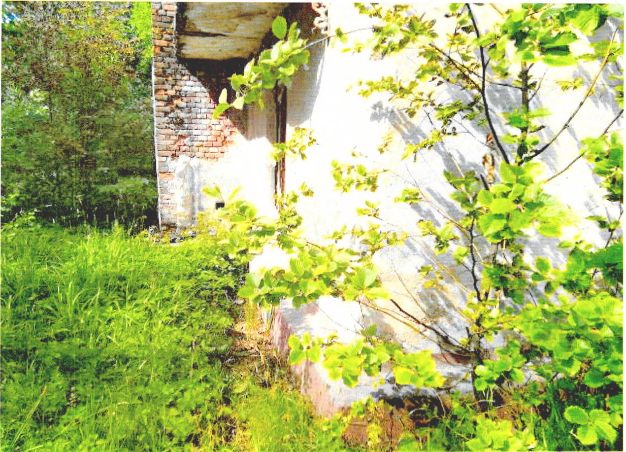
Фото 4. Юго-восточный угол здания.
