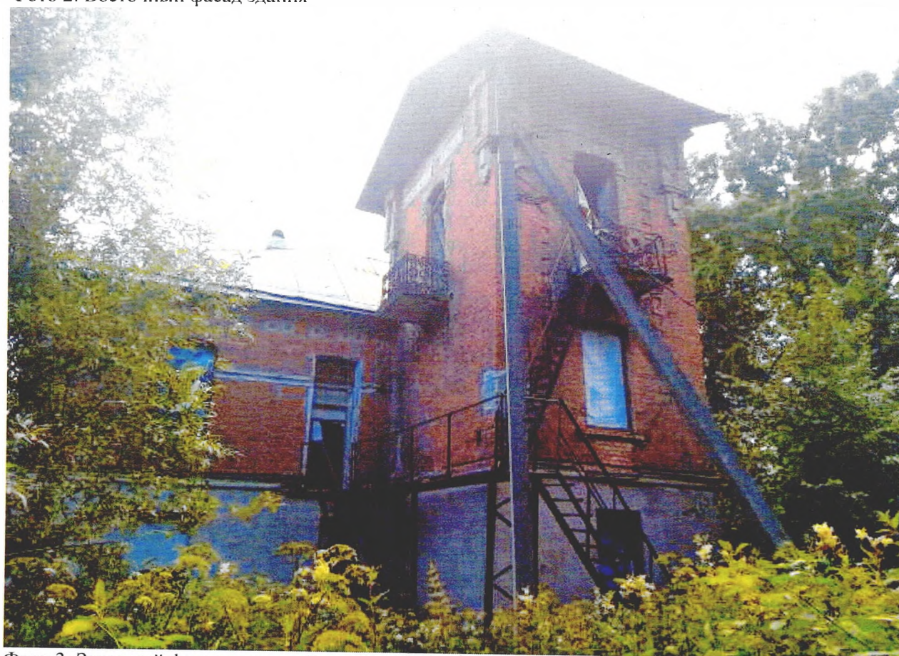
Фото 3. Западный фасад здания с 3-х этажной башней.
