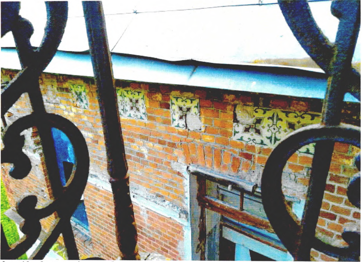
Фото 10. Фрагмент фриза из большемерных керамических плиток.
