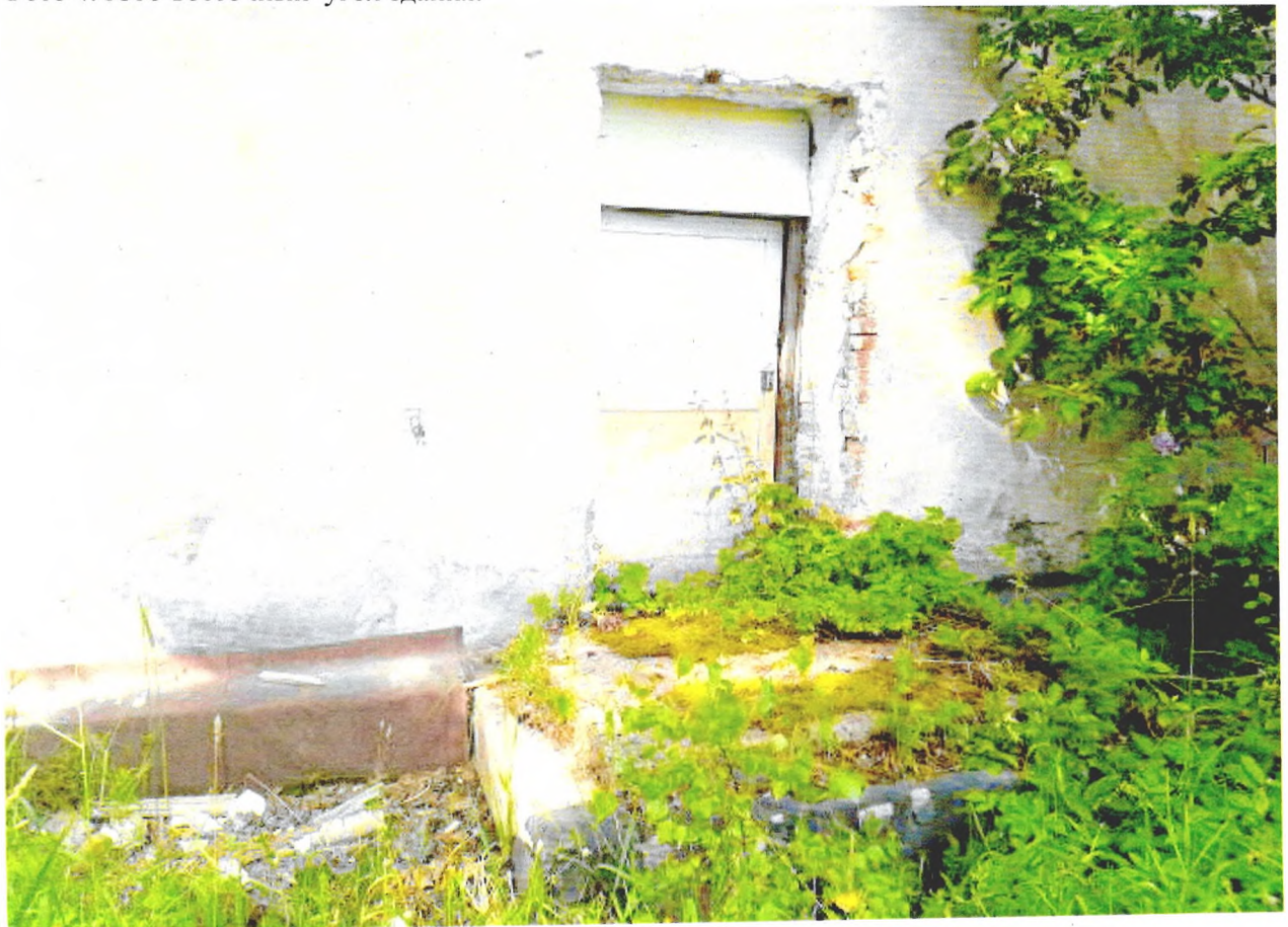
Фото 5. Вход в здание с восточной стороны.
