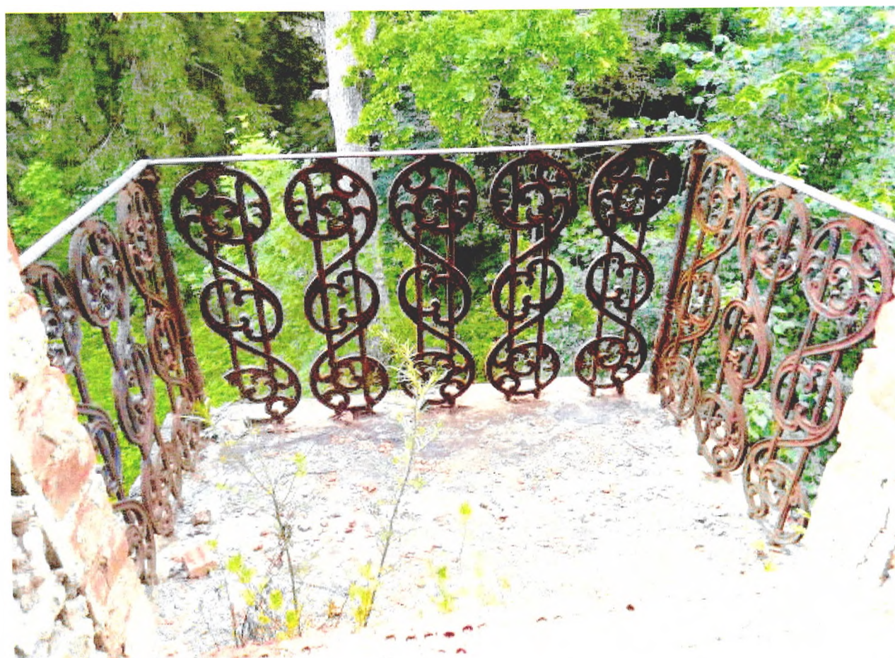
Фото 9. Ограждение балкона 3-го этажа башни.
