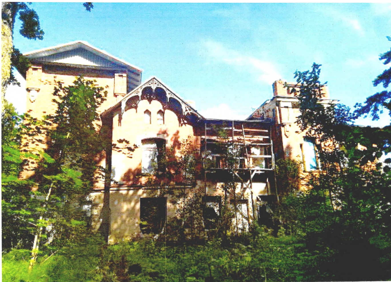
Фото 1. Южный (главный) фасад здания.
